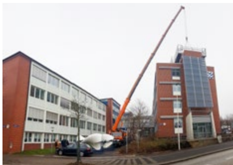
Kurz vor Weihnachten konnten die beiden Turbinen auf dem Dach von C13 in Position gebracht werden.
