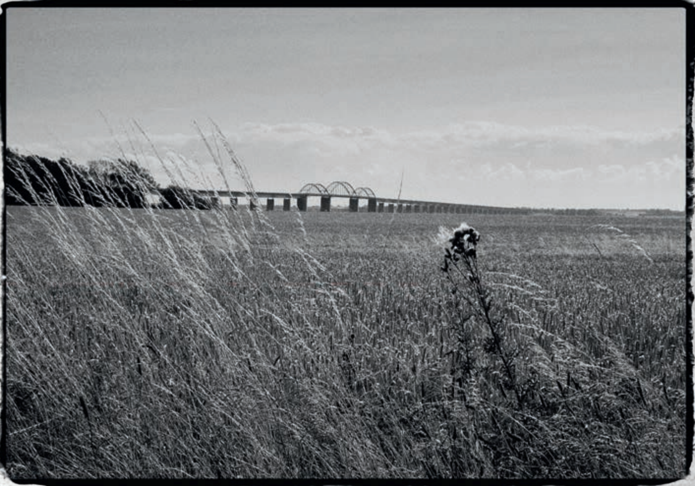
Die 3,2 Kilometer lange Storströmbrücke verbindet die dänischen Inseln Falster und Seeland. Nach einer windigen Überquerung in 26 Metern Höhe haben wir uns über diesen Anblick gefreut.
