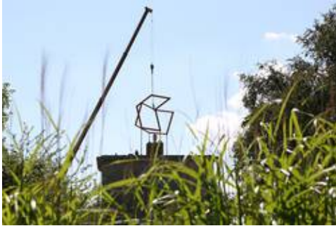
Fest zusammengebaut und frisch lackiert geht es ab auf's Bunkerdach (Foto: Denise Walter)
