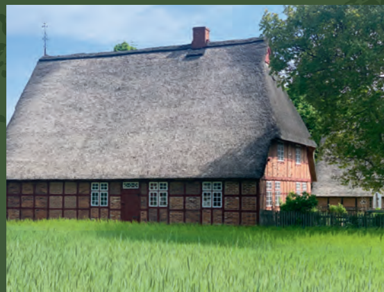
oben: Ein klar gegliederter Steilgiebel mit Holzverbretterung
