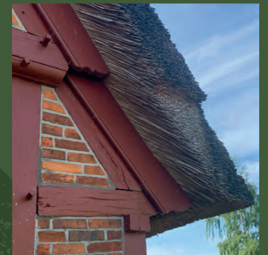
Gebrannte Ziegel aus heimischen Ton mit großer Fuge
