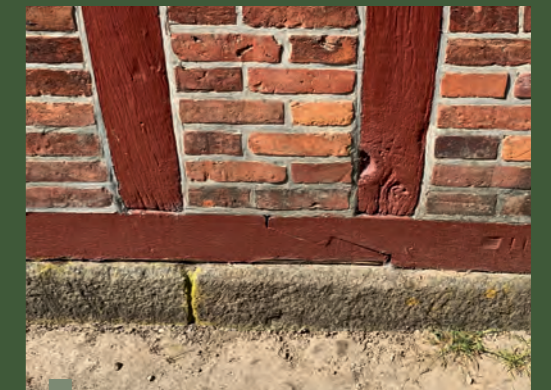
Gebrannte Ziegel aus heimischen Ton mit großer Fuge
