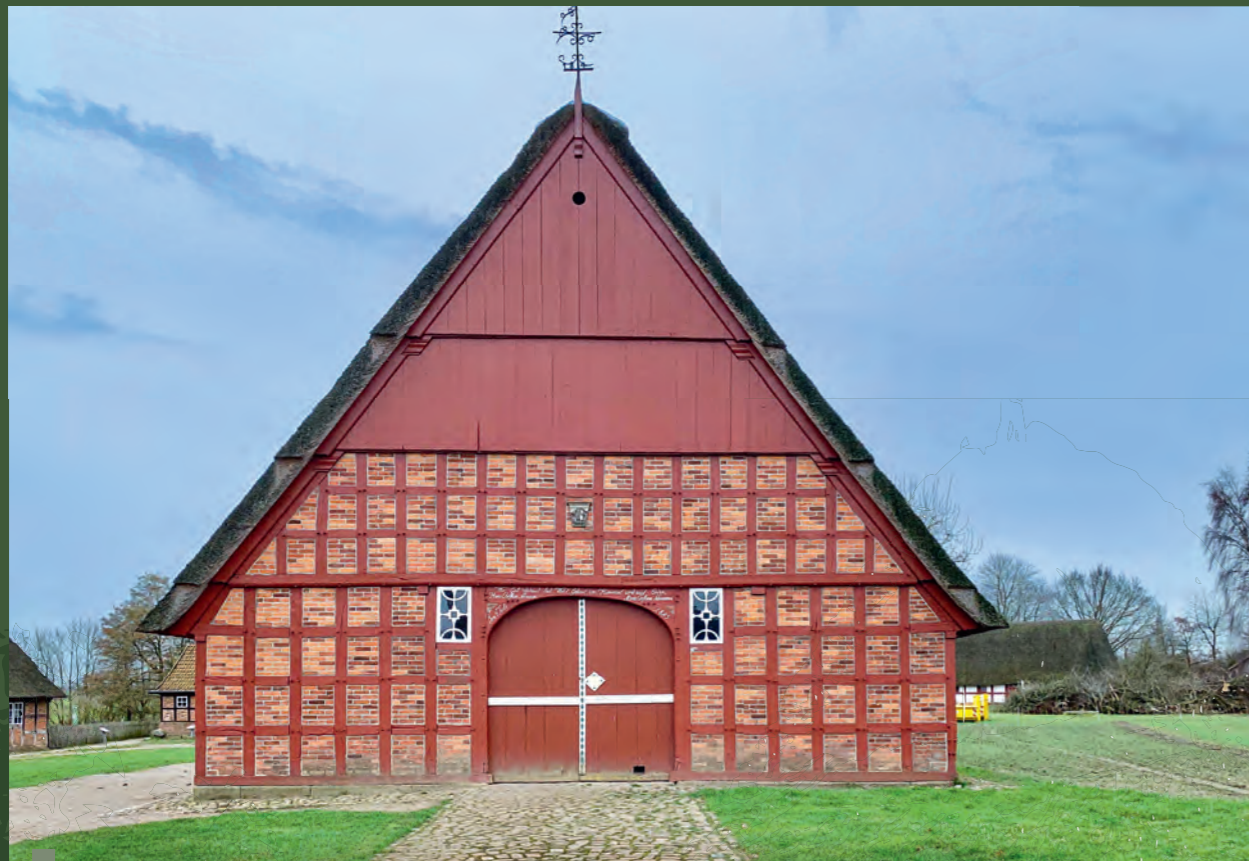
oben: Ein klar gegliederter Steilgiebel mit Holzverbretterung
