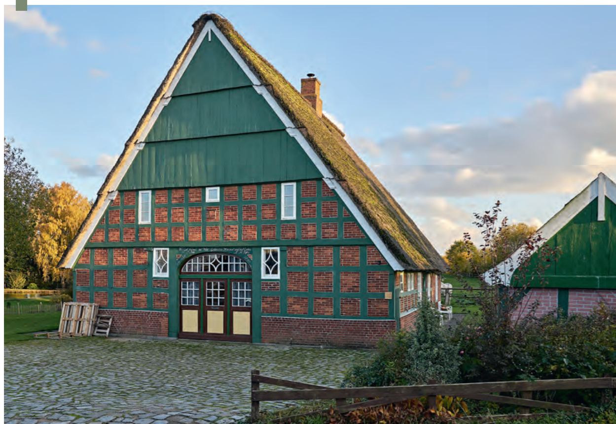
Restauriertes Bordesholmer Haus der Familie Behnfeld in Groß Buchwald
