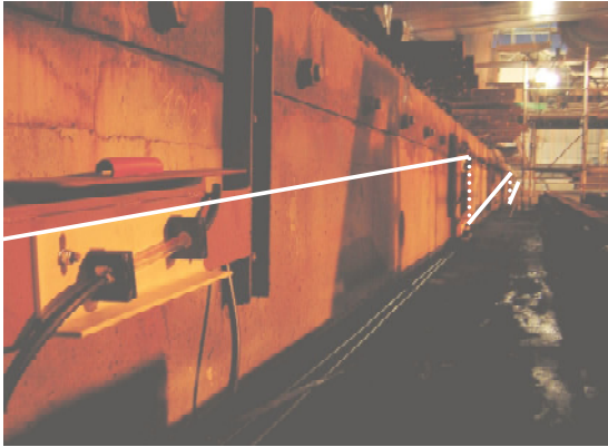
Abbildung 2.4: Messsystem am Ablaufbalken Die Qualität der Ablesung unter Seewasser zeigt Abbildung 2.5: Die Teilung beträgt 5mm, entsprechend 0,5mm Hub. Der Ablesewert von 2,80 muss mit denen der anderen Gläser zu einer Biegelinie weiterverarbeitet werden.
