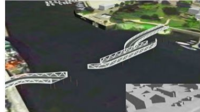
Eine Variante die Verschubbrücke. Damit Schiffe von der Schwentine zur Kieler Förde gelangen, wird ein Teil der Brücke hydraulisch versetzt
